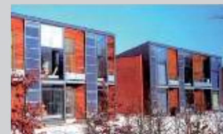
Inserimento di serre e pareti di accumulo
