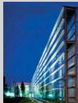
Inserimento di soluzione a doppia pelle per aumentare il comfort interno.
