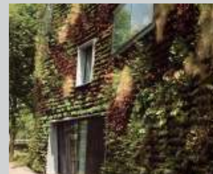
Uso del muro verde per aumentare l'isolamento delle pareti
